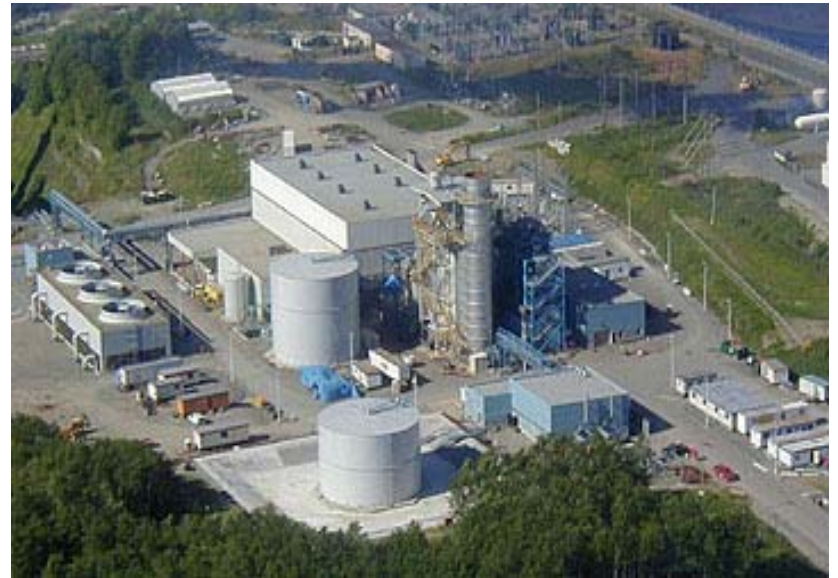
Calpine 250 MWe Island Cogen, Van. Is.
